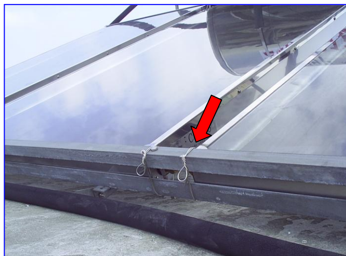
圖 2：綁上鋼絲示意圖
