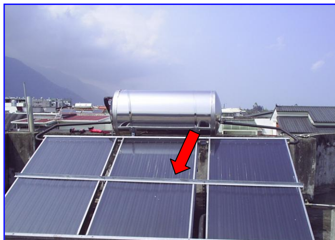
圖 1：加橫桿補強示意圖
