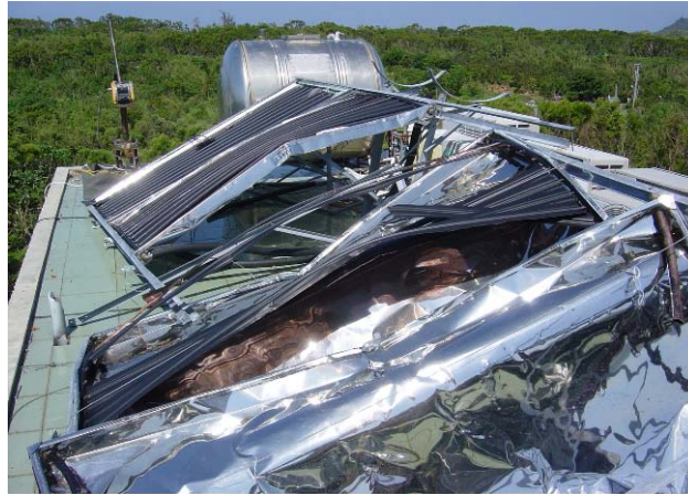
圖二、因颱風受損之太陽能熱水系統
